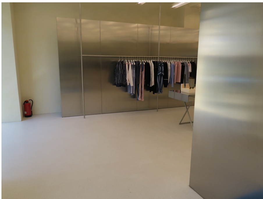
Weißer Terrazzoboden mit Feuerlöscher
