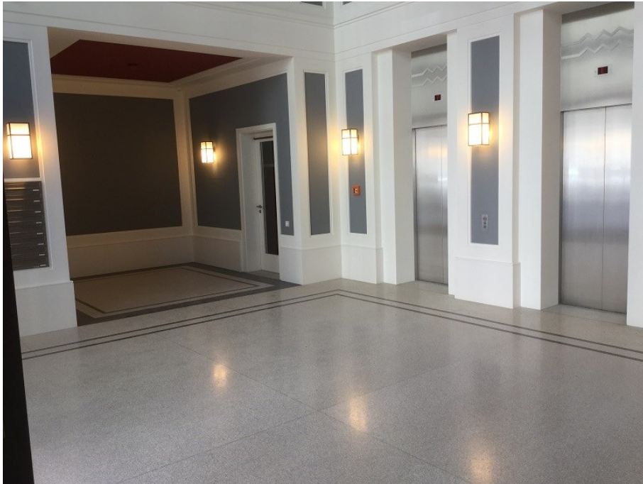
Heller Terrazzo mit Frieseinlegearbeiten im Foyer
